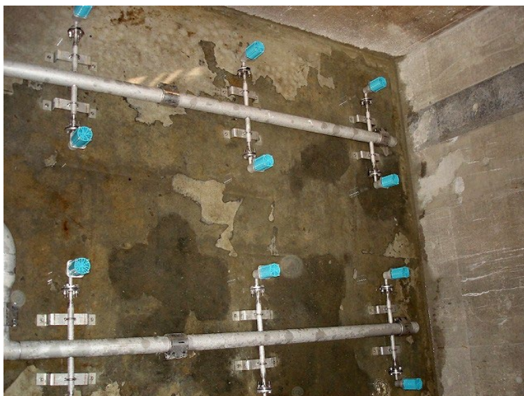
調整槽内部配管
