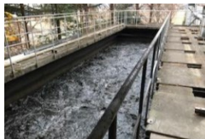
糖質製造工場曝氣槽
