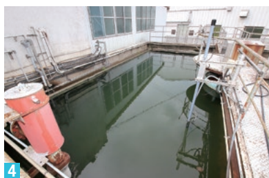
1 木綿豆腐完全自動化製造機の一部。日本初の第1号機は1989年に開発された 2 ばつ気槽に送る水量の調整を行う調整槽。最初にアクアブラスターを設置した水槽だ 3 微生物を活性化させるばつ気槽。アクアブラスターによる効果的な散気と攪拌が行われている 4 沈殿槽。水の透明度はかなり高い。写真右側の奥に見えるのは、底にたまった汚泥が固まらないようかき回す装置
