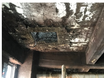
硫化水素で腐蝕した天井
