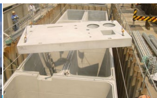
弁当工場の排水処理
