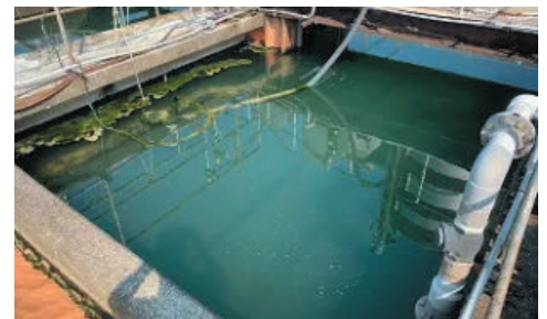
濁りのなくなった沈殿槽
