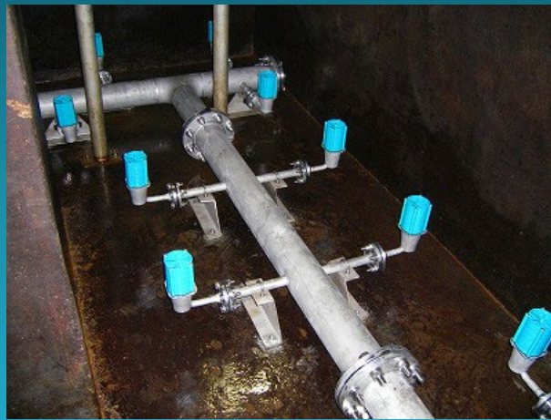
散気管アクアブラスターを設置した状態
