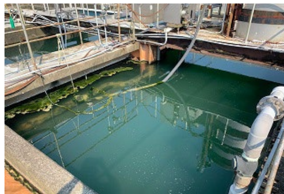
濁りのなくなった沈殿槽
